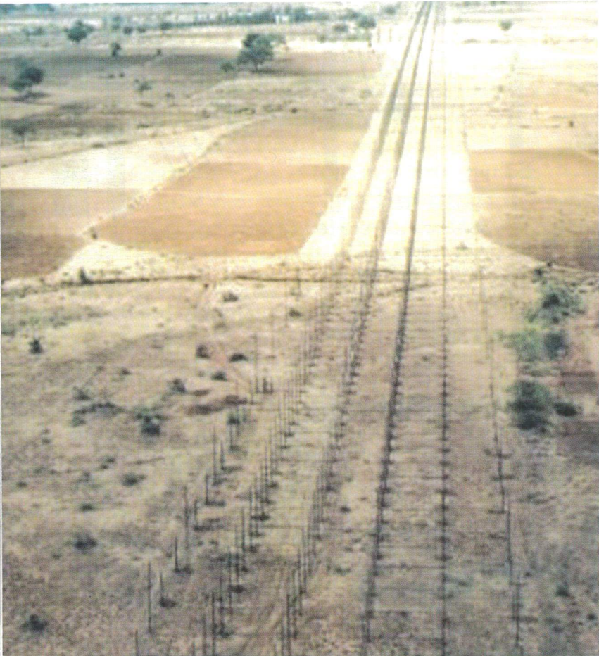
1 km X 0.5 km ಅಳತೆಯ ಗೌರಿಬಿದನೂರು ದೂರದರ್ಶಕದ ಡೈಪೋಲ್‌ಗಳ ವಿನ್ಯಾಸ ಮೇಲಿನ n ಆಕಾರದಲ್ಲಿ C to N3 ಉತ್ತರ ದಕ್ಷಿಣವಾಗಿ ಮತ್ತು C to E3 ಪೂರ್ವ ಪಶ್ಚಿಮವಾಗಿ ಇರುವ ಆಯತಾಕಾರದ ಸಂಗ್ರಹಣೆಯ ಸಾಮರ್ಥ್ಯ ಪಡೆದುಕೊಂಡಿದೆ.
